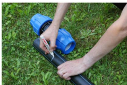
2. Marker innstikkdybden på rørenden. Instikkslengden er markert på koblingen.
