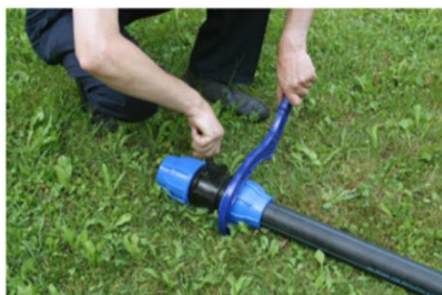
4. Stram til koblingen med hendene. For størrelser over d25, stram ekstra med en spesial nøkkel for magnum koblinger.
